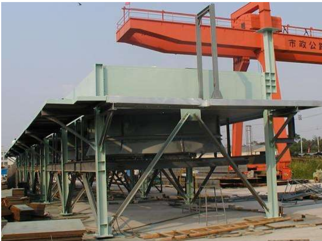
日本国内 向け 出荷前の仮組 2003 年完成
